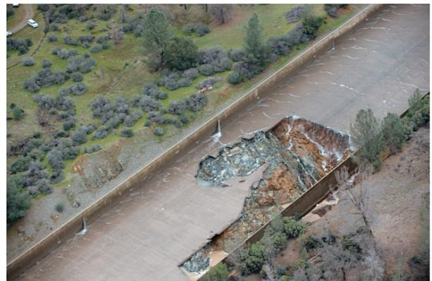
写真—5 常用洪水吐きシュート部の損傷（空中写真）
