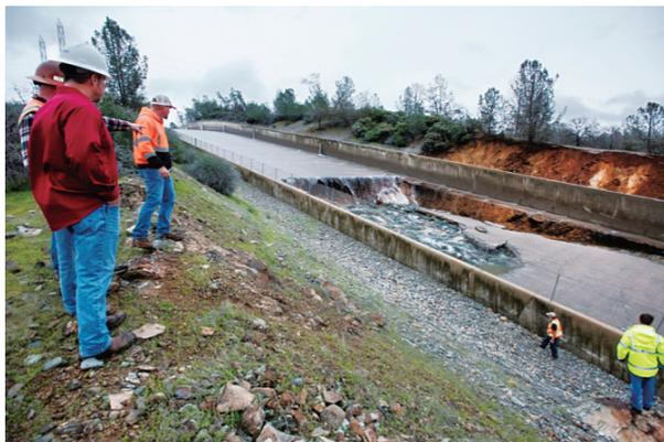
写真—4 常用洪水吐きシュート部の損傷（地上写真）
