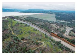
写真-3 シュート部の損傷(出典:州水資源局)
