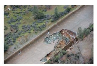
写真-5 常用洪水吐きシュート部の損傷(空中写真) (出典:州水資源局)
