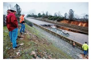
写真—4 常用洪水吐きシュート部の損傷(地上写真) (出典:州水資源局)
